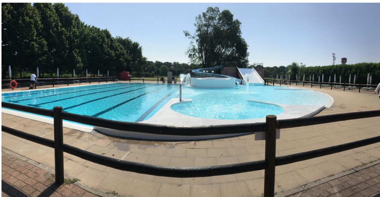
La piscina esterna del Centro Sportivo di Cassano d’Adda dopo i lavori di ammodernamento
